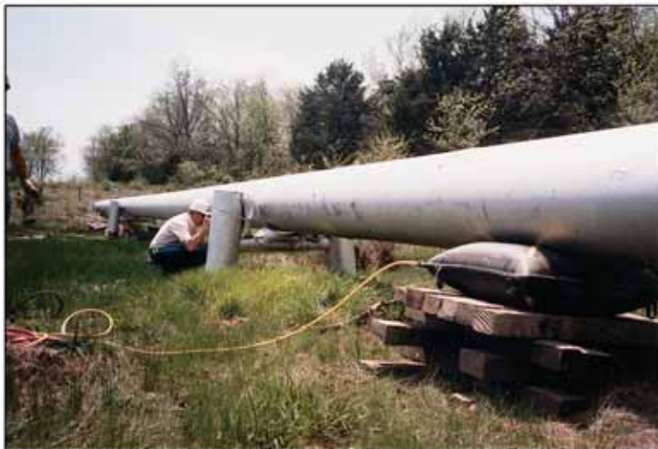
Soulever et niveler des pipelines inaccessibles aux équipements lourds.
