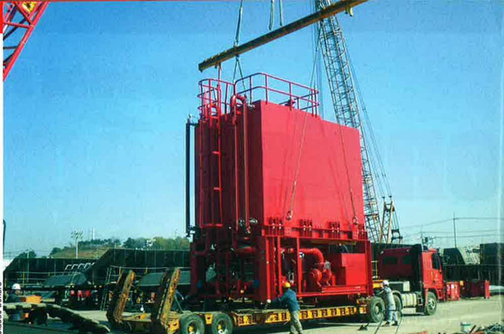
Installation d'un système de dosage d'émulseur (pompe plus réserve d'émulseur) fabriqué par Eau et feu lors de la construction de la plate-forme pétrolière Pazflor en Corée. Cette plate-forme de type FPSO (système flottant de production, de stockage et de déchargement) est aujourd'hui au large de l'Angola.
